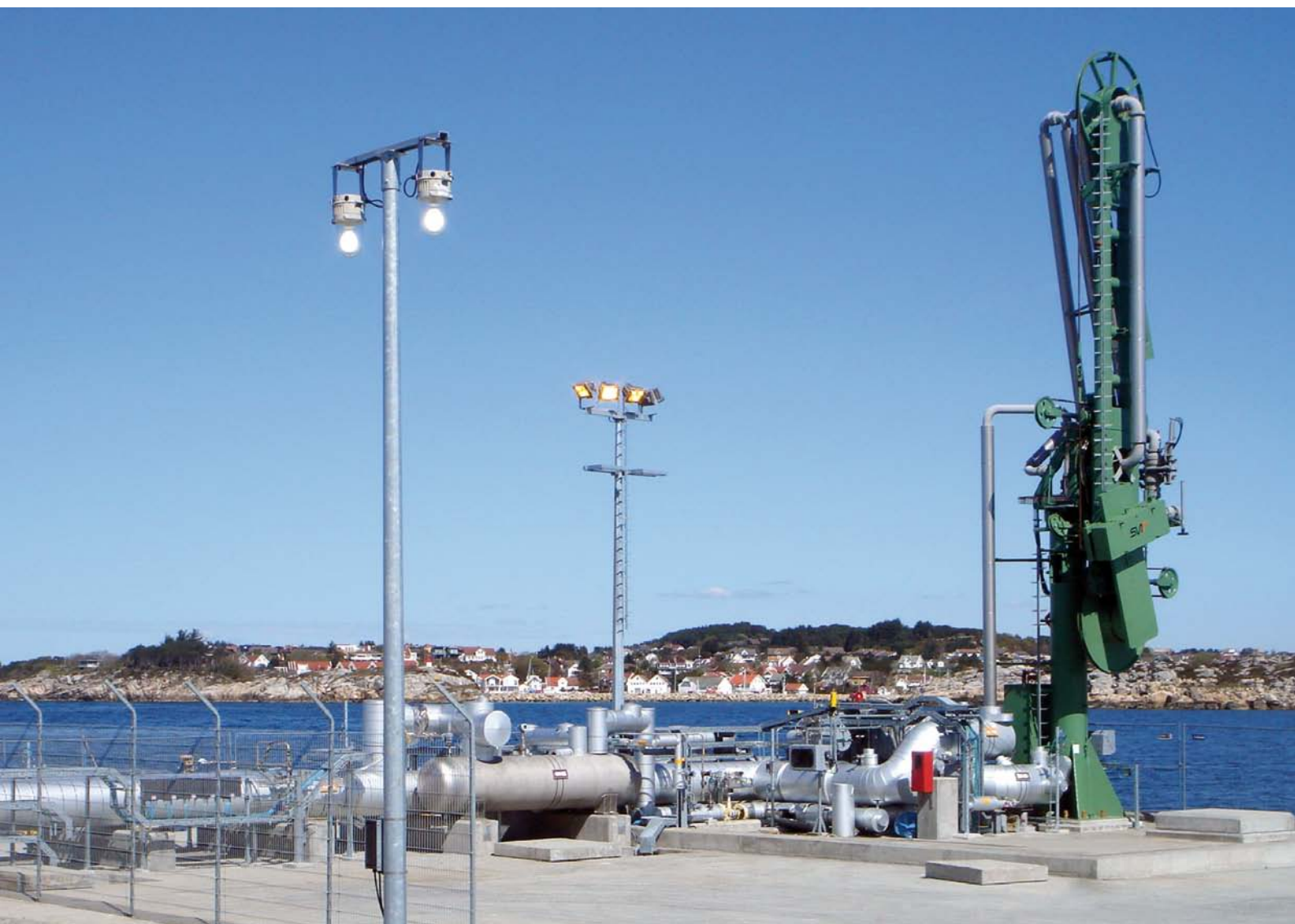
LNG ship loading arm installed on the jetty of the Stavanger LNG plant
